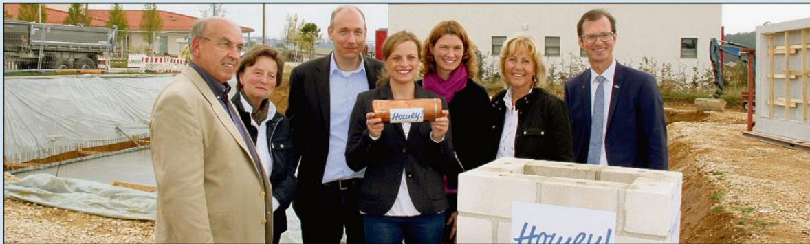
Gerd Schmid, Hella Schmid (beide Feinkost Schmid), Felix und Stefanie Baldermann (Inhaber), Landrätin Tanja Schweiger, Barbara Wilhelm (Bürgermeisterin Pentling) sowie Bauunternehmer Michael Regnauer (v. li.) bei der Grundsteinsetzung
